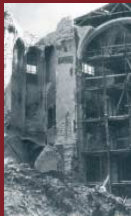
Zawalona ściana katedry
